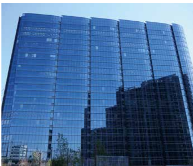
●住友不動産大崎ガーデンシティ(東京) 設計:日建設計 施工:大成建設 ペアマルチLow-E ブルー 60
