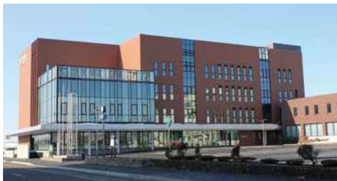
●砂川市庁舎(北海道・新築) スーパースペース
