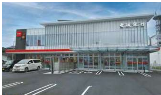
●愛媛銀行西条支店(愛媛・新築) スーパースペース ※BELS「ZEB」認証取得
